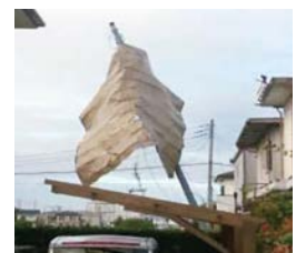
飛来物による電柱倒壊（東金市）
