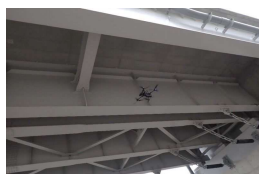
ドローンによる桁下の点検
