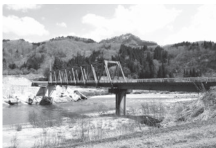
▲4/6に開通した五礼橋
