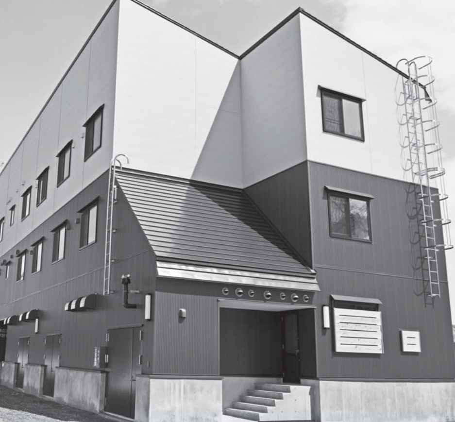
▲3月23日に竣工した奥会津学習センター
