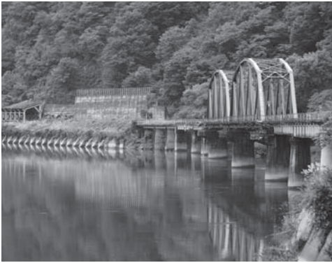
▲増水に備え安全対策として橋りょう全体の嵩上げ案が示された寄岩対岸の「第8橋りょう」。再試算された復旧費は52億円(当初より7億円増)
