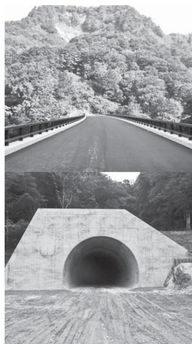
▲全通に向けて工事がすすむ八十里越(4号橋梁と7号トンネル)(写真提供)長岡国道事務所
