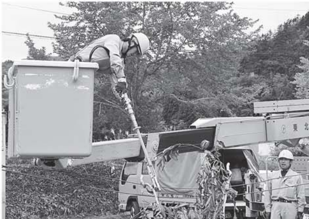
▲東北電力による応急復旧作業訓練
