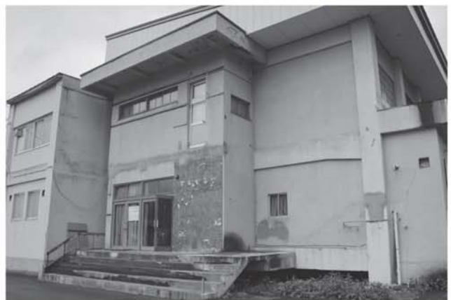
▲ 現在民具が管理・保管されている収蔵庫
