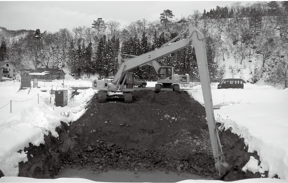
▲黒谷浄水場が設置される水源地での試掘状況
