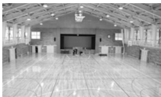
耐震改修済の只見中体育館
