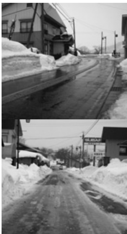
上/消雪パイプ設置道路 下/未設置道路
