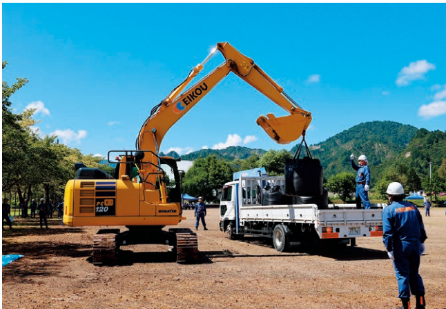
▲建設業協会と町消防団が連携し、大型土のう袋を使用した土のう積訓練
