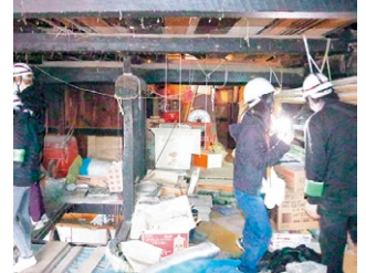
古民家調査の様子
