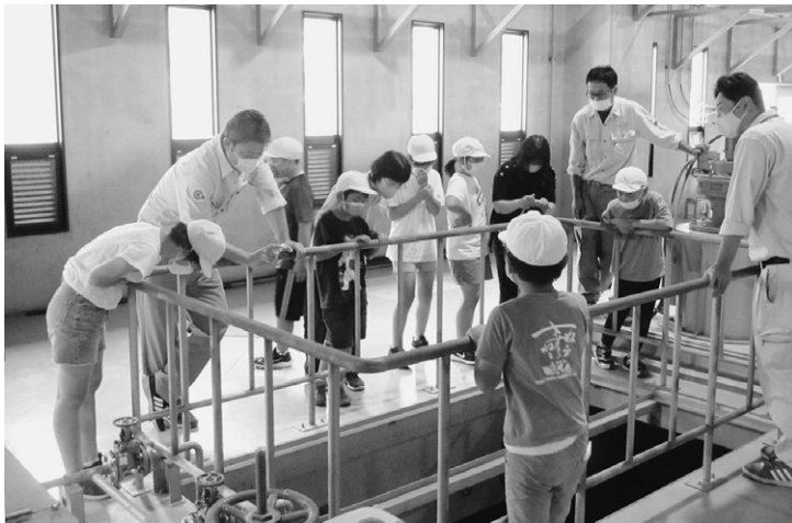
▲沈でん槽設備に興味津津でのぞきこむ朝日小児童
