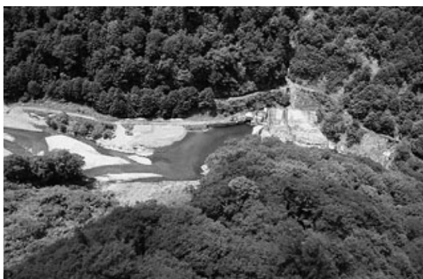
林道が崩壊し容易に近づけない黒谷ゴムダムの様子 ヘリコプターによる豪雨災害の被害状況視察時に撮影
