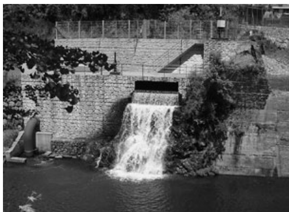
視察に訪れた高知県梶原町の小水力発電施設
