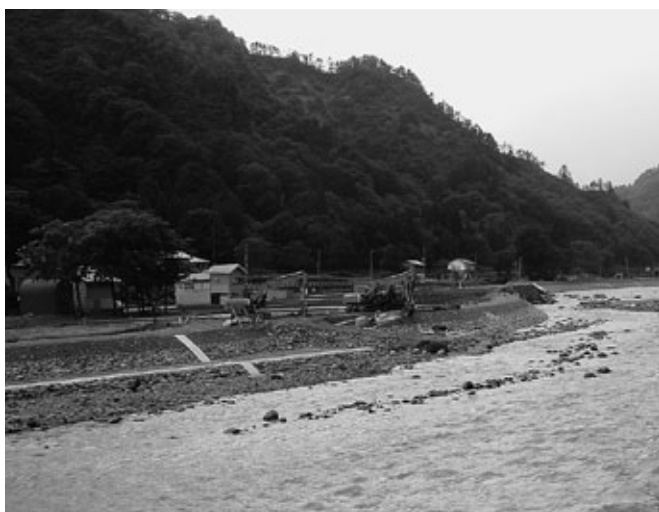
豪雨災害の復旧工事現場（叶津）
