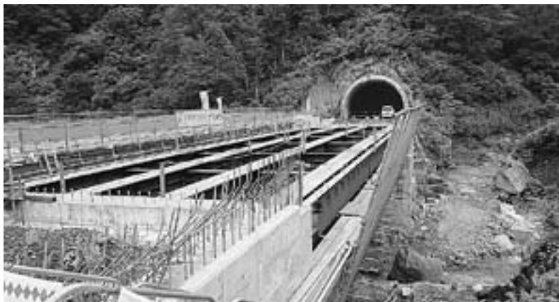
289号県境トンネルへ通じる7号橋梁工事現場（只見町側）
