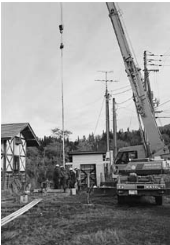
源泉ポンプ入れ替え作業の様子
