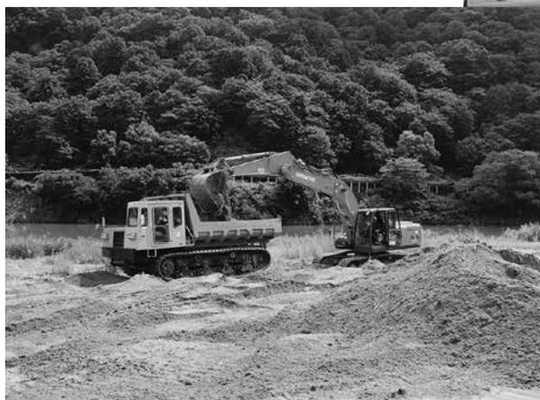
堆砂の掘削、積み込み状況（十島地内）
