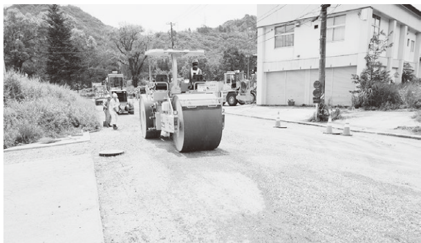
傷んだ町道舗装整備
