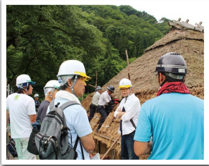
旧五十嵐家住宅保存修理事業見学会
